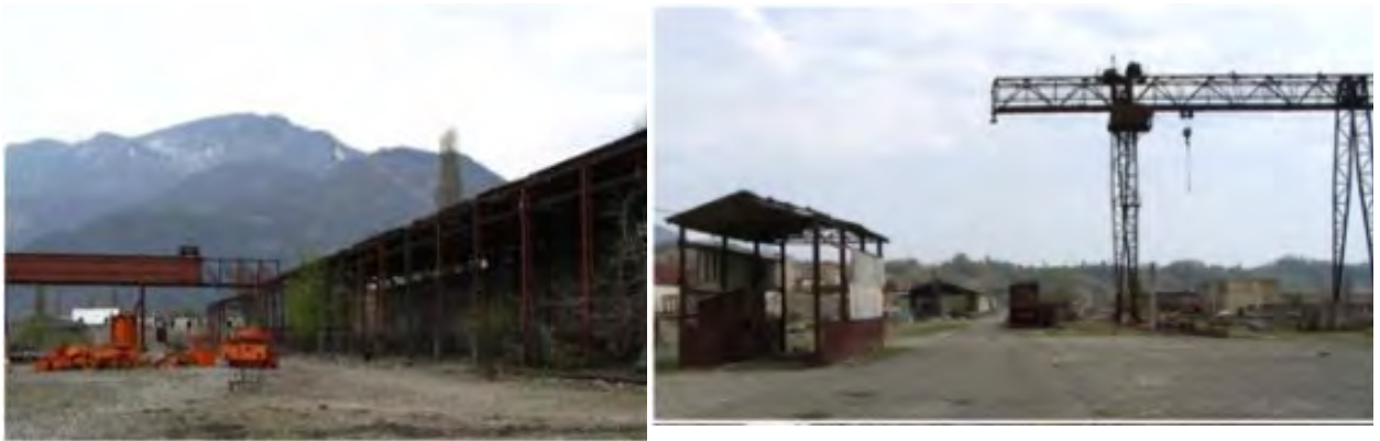
სურ. 4.10, 11, 12, 13. შესანახი და სასაწყობო მეურნეობების ფართობები, შენობები და ამჟამად სატრანსპორტო საშუალებები სოფ. ჯვარში, რომელიც ხუდონის ჰესისათვის არის გათვალისწინებული.
